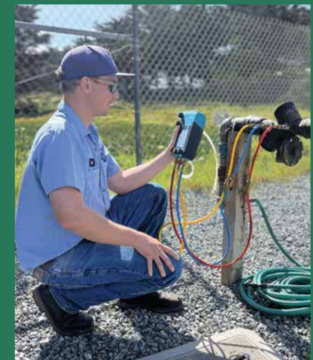
(Kaliwa) Operator na gumagamit ng generator upang matiyak ang tuluy-tuloy na serbisyo sa panahon ng pagkawala ng kuryente. (Sa itaas) Sinusuri ng operator ang backflow device upang matiyak ang wastong paggana.
