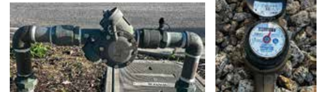
Mga halimbawa ng isang backflow device (sa ibaba) at isang metro ng tubig (kanan).
